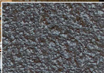
フォーク通路面 滑り止めコート塗布
