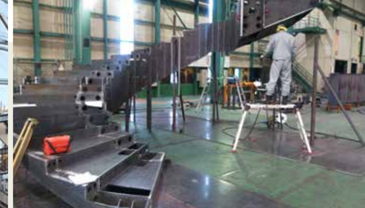
赤坂迎賓館前公園施設内階段の製作風景。階段の製作は、つくばの自社工場で行い設計から施工まで一貫したシステムで管理
