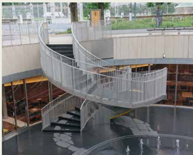
赤坂迎賓館前公園施設 場所：東京都、設計：TAK建築研究所、施工：鉄建建設、施工年：2020年
